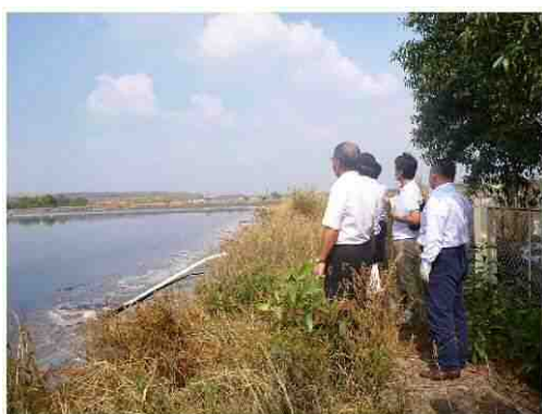
浸出水調整池の確認
