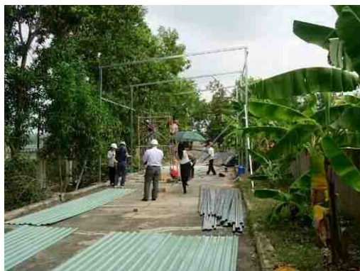
図3-1-11 実験プラント建屋施工
