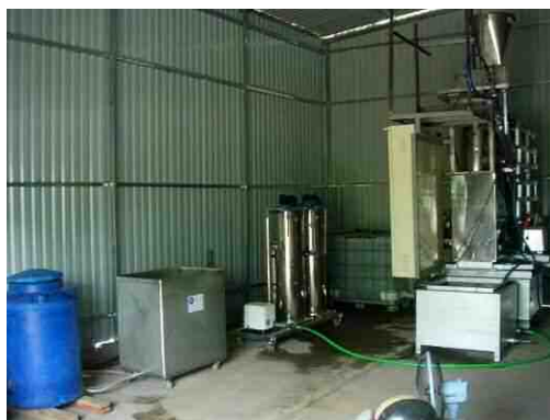
図3-1-14 実験プラント設備
