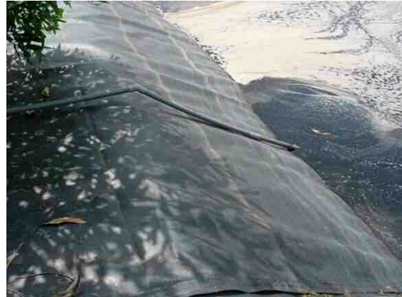
図3-1-7 原水取水パイプ
