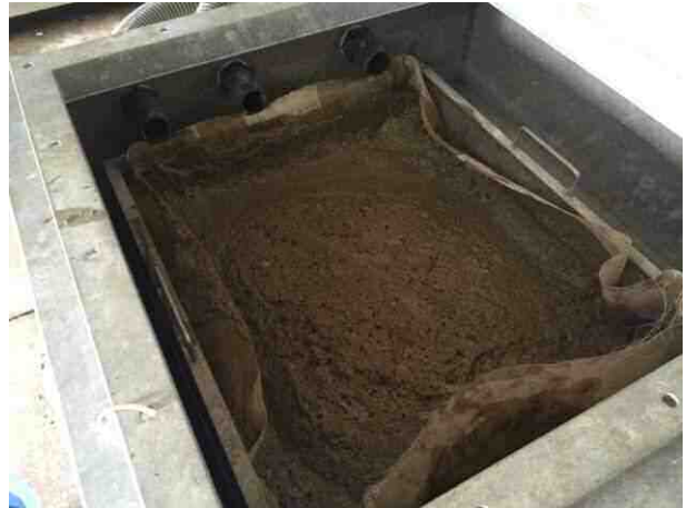
Pic6. スラッジ受け槽 (凝集剤により分離したスラッジ)
