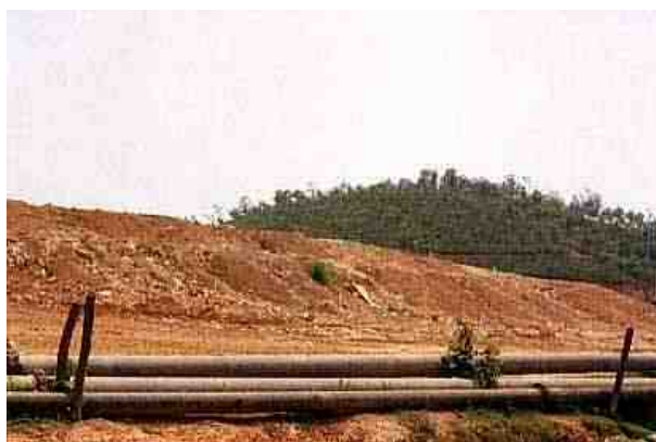
図1-2-3 浸出水集水管
