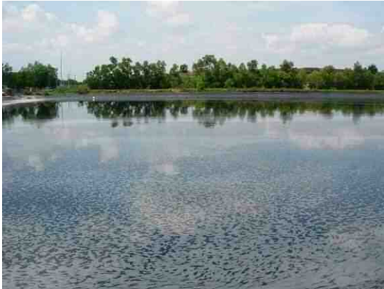
図3-1-6 浸出水調整池
