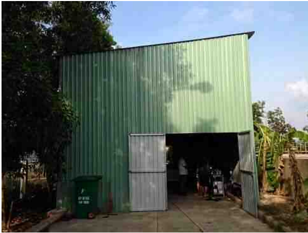
Pic1. 実験プラント建屋外観
