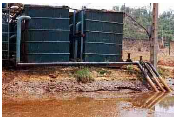
図1-2-4 浸出水調整池と貯槽タンク
