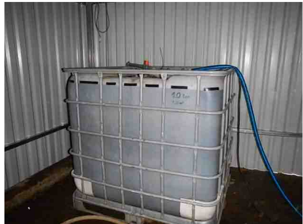
Pic4. 原水タンク(容量1m 3 )
