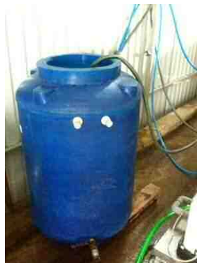
図3-2-9 最終処理水タンク
