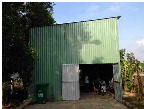
図3-1-12 実験プラント建屋外観
