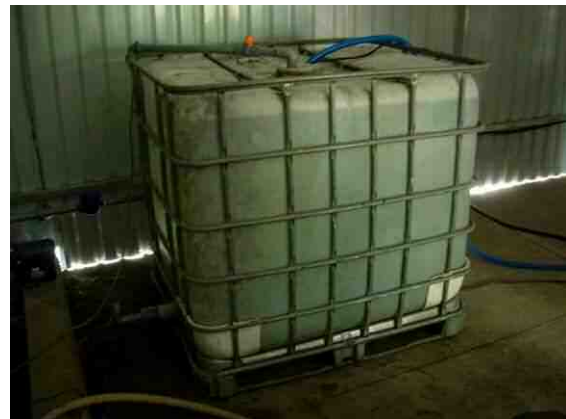
図3-1-9 原水貯水タンク
