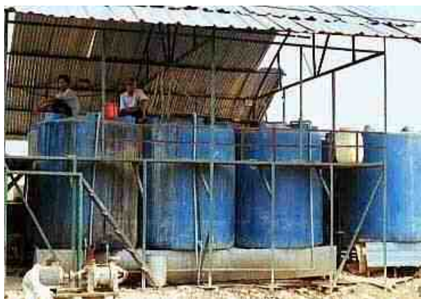
図1-2-5 浸出水処理タンク
