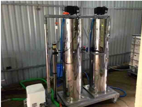
Pic7. シャイニー波動蘇水器・高性能ろ過器 (スラッジを分離した一次処理水を最終処理する)
