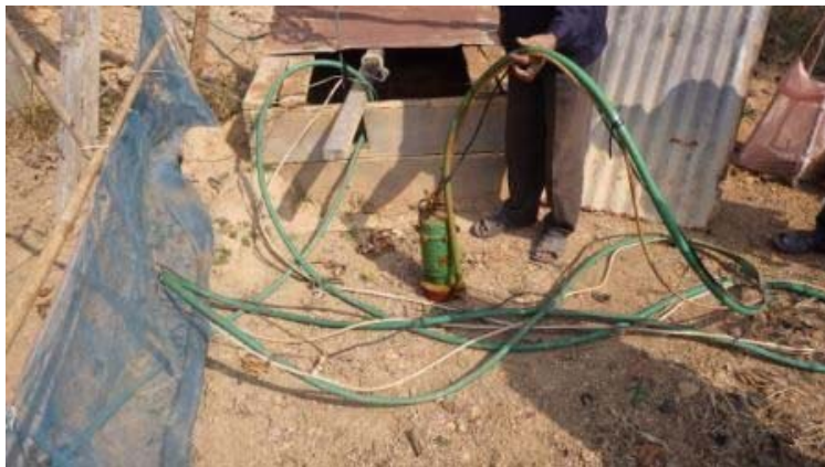
井戸の揚水ポンプ（水中ポンプ）
