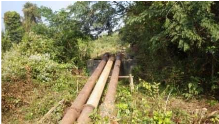
ヌー川からの農業用水の揚水配管状況
