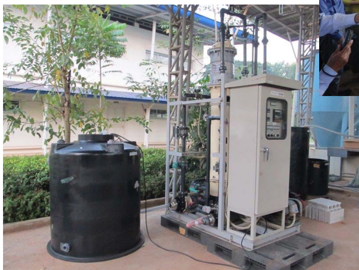
チナイモに設置したろ過施設
