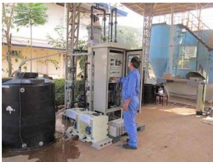
写真 6 通水テストの状況
