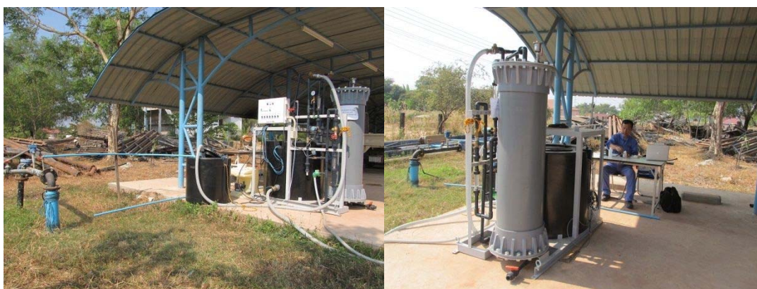
写真 13 除鉄除マンガン除去試験の状況（左：装置全景 右：通水テスト状況）
