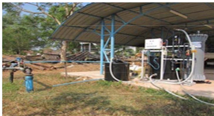
写真 4 Site2 パクサン浄水場
