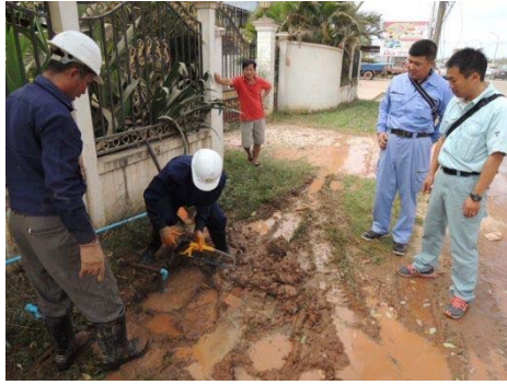
写真 19 給水管の漏水修繕状況
