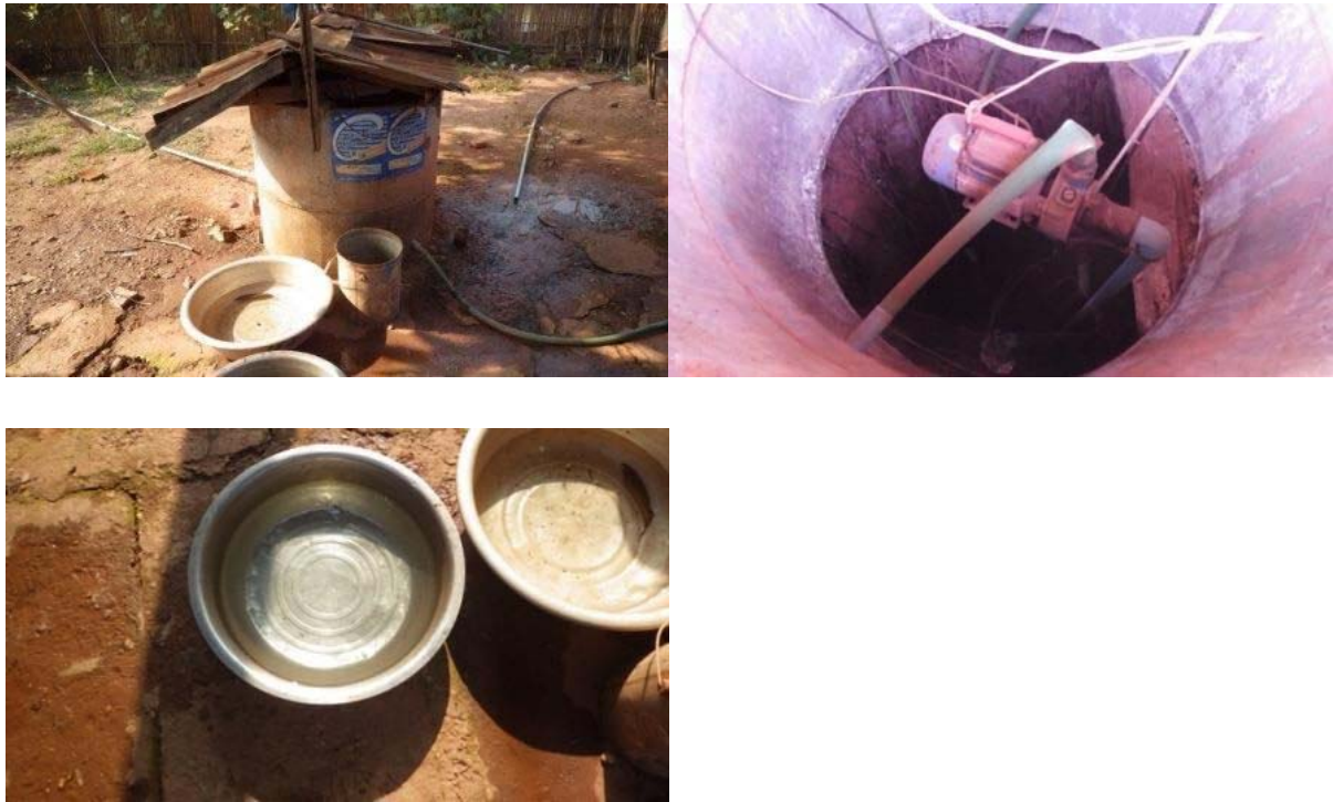
写真 2 井戸水の使用状況 (BANPHOMESAY 地区) (上左：井戸全景 上右：横置き吸い込み井戸ポンプ 下左：井戸水の状況)
