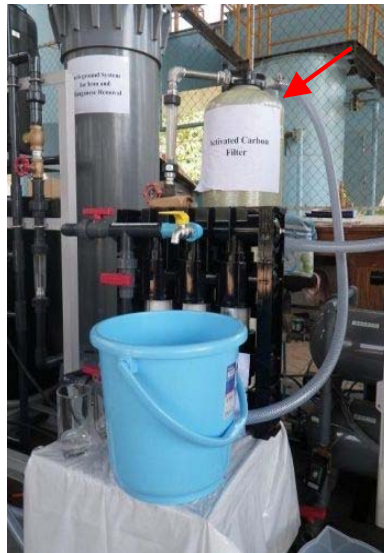
写真 9 活性炭吸着装置の設置状況
