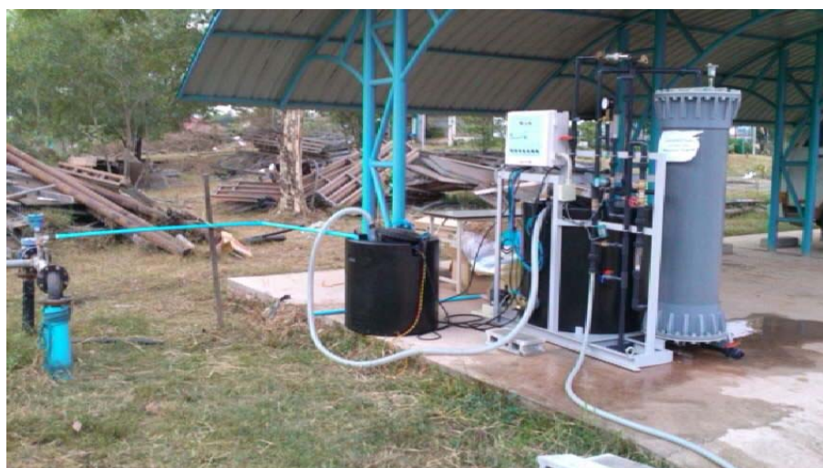
パクサンに設置した浄水施設
