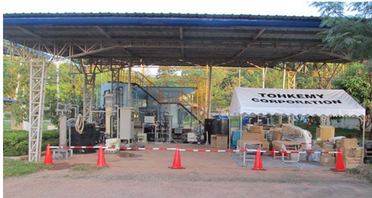
写真 3 Site1 チナイモ浄水場隣接トレーニングセンター
