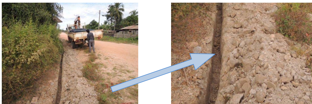
写真 18 掘削・埋戻しの状況
