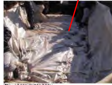
現場写真—土質の軟弱なため作業は
