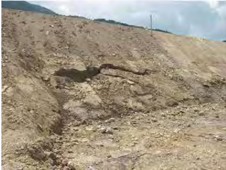
大雨翌日の法面の倒壊状況
