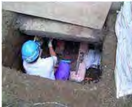
D・BOX上部に油圧ジャッキをセット
