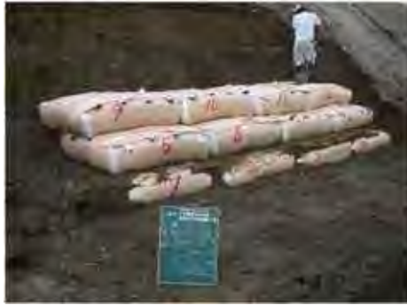
D・BOX-LS150 敷設状況
