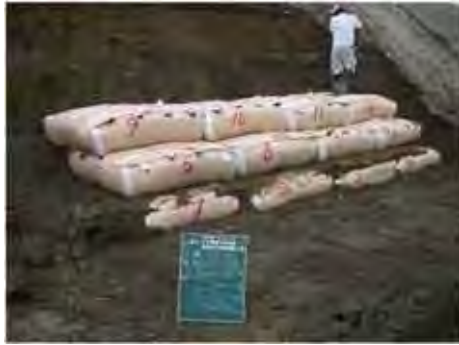
D・BOX-LS150 敷設状況
