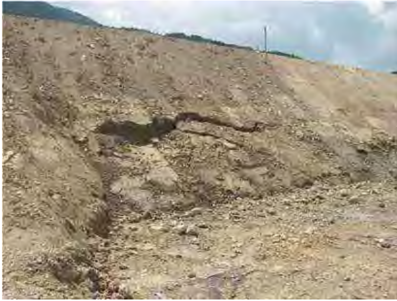
大雨翌日の法面の倒壊状況
