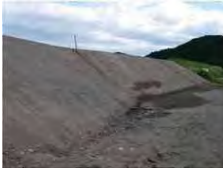
D・BOX敷設後 台風翌日の状況 反対面の法面は倒壊している。
