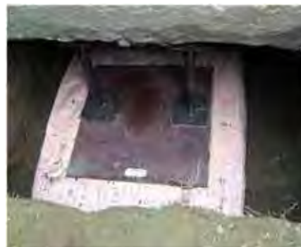
リフトアップ後サポートジャッキにて固定
