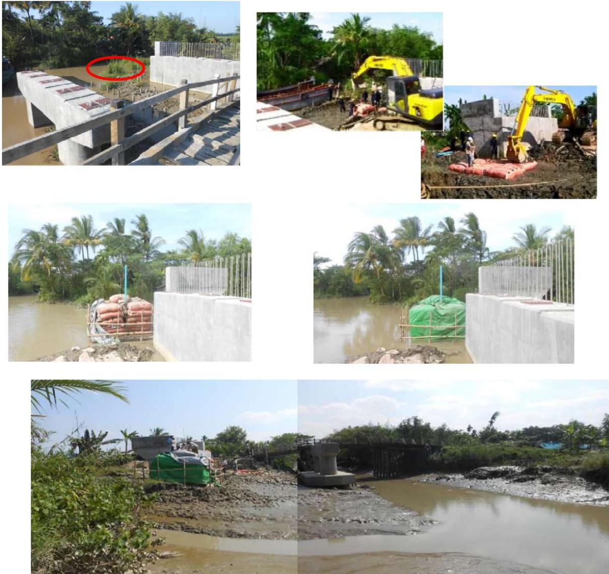
図 3.2.14 軟弱地盤上のD・BOX基礎への荷重盛土試験
