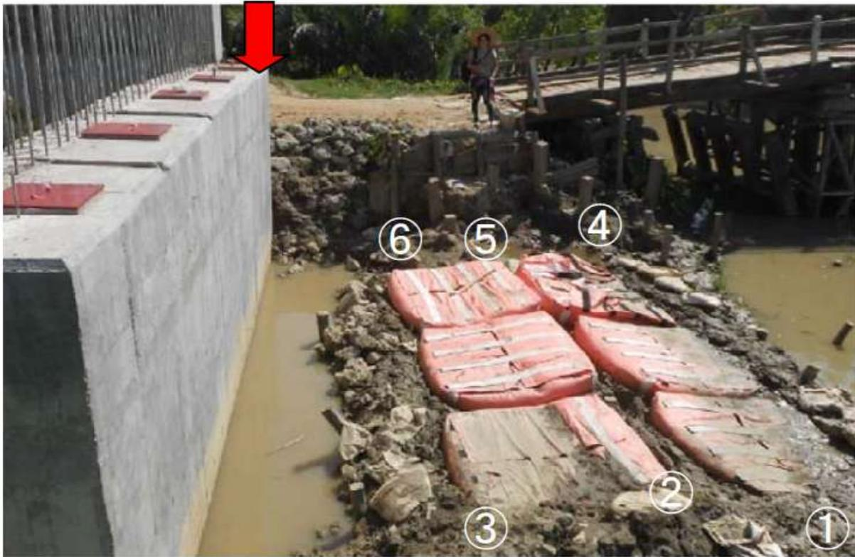
図 3.2.11 沈下測定計測点
