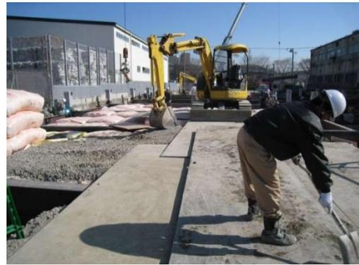
製造機械下部では、常時最大 115kN/m<sup>2</sup> の荷重が作用している
