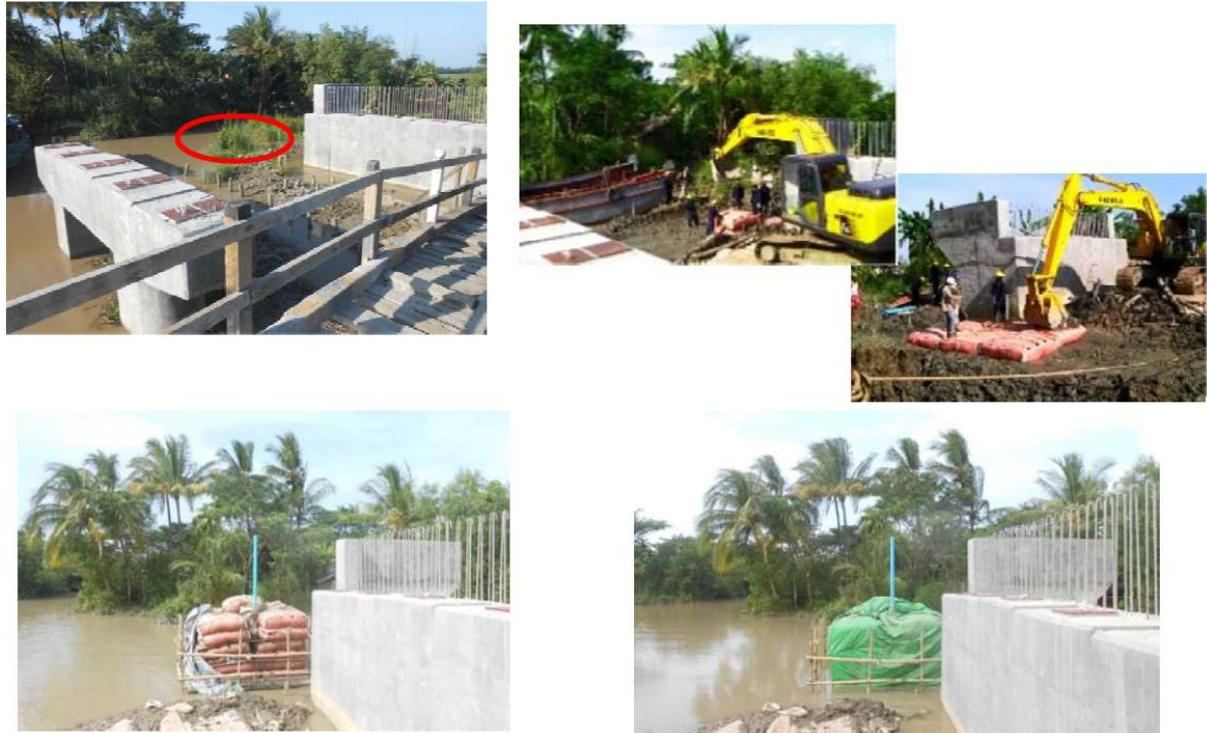
図 3.1.8 軟弱地盤上の D・BOX 基礎への载荷盛土試験
