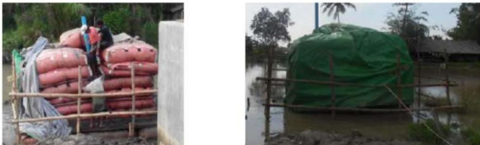
図 3.2.24 D・BOX の設置状況
