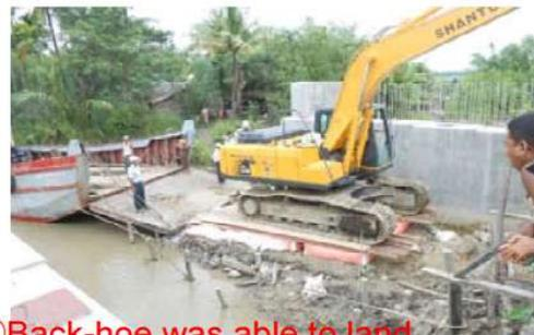
図 3.1.7 仮設足場の設置状況 (27tバックホウの作業足場)
