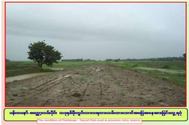
図 2.4.13 パテイン～ヤンゴン間の鉄道建設中の軟弱地盤状況
