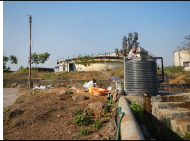
PVC タンク内での濁水生成作業の様子
