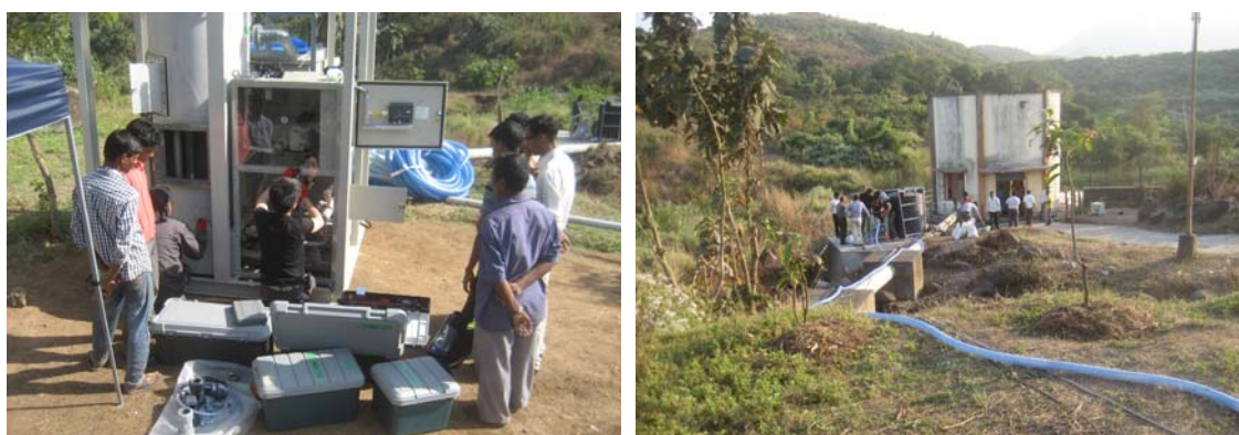
図 3-6 リーチフィルターの設置後の状況
