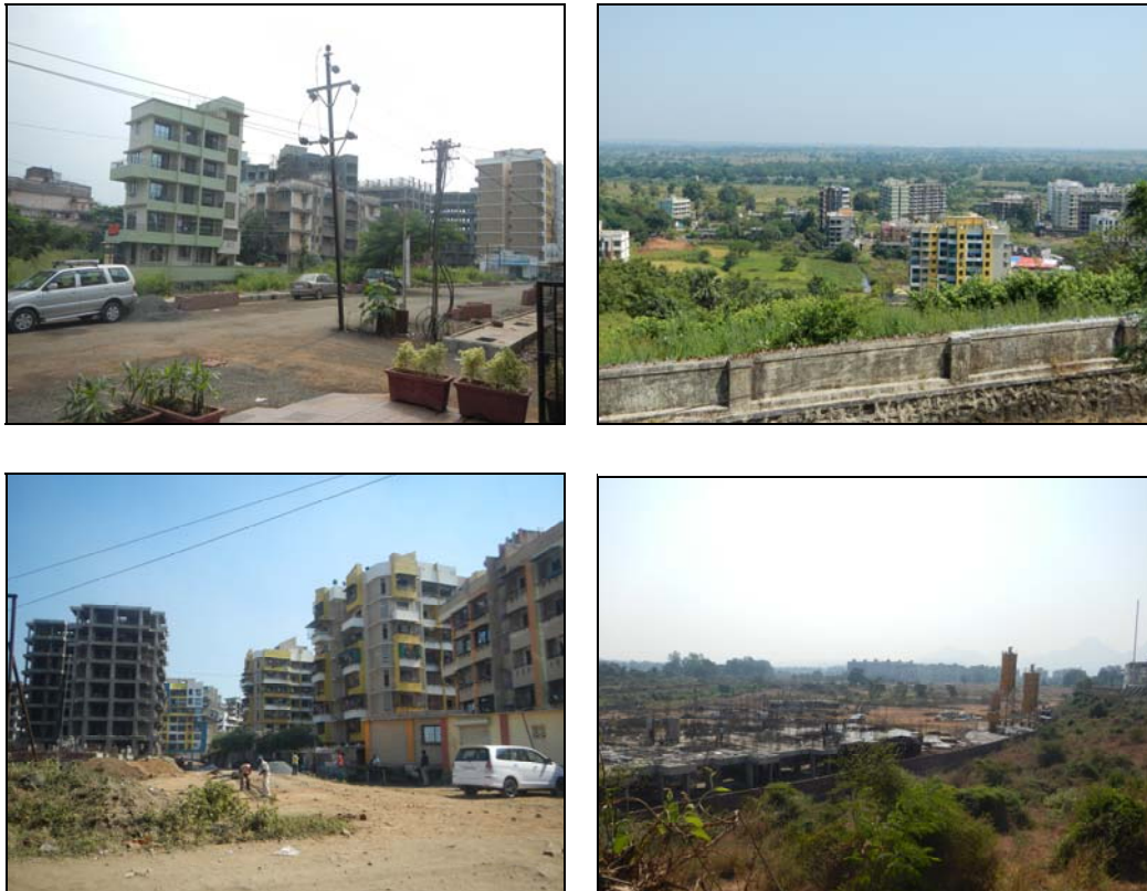
図 1-5 Badlapur 市内のアパート建設ラッシュの状況
