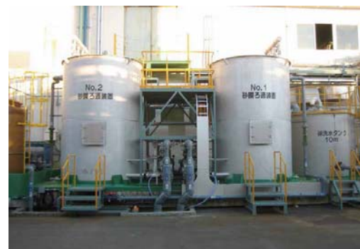
日本で運用されているリーチフィルター (処理能力 2,000m 3 /日)
