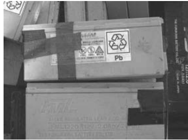
通信用・非常用設備・OA機器バックアップ用 拡大写真
