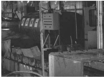
廃酸は専用タンク積替保管後、処理工場へ排出
