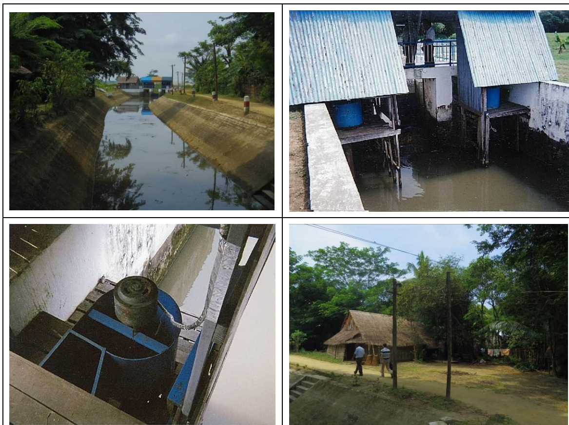
Kantinbeelin Damからの水路に設置されている小水力発電：3KW
