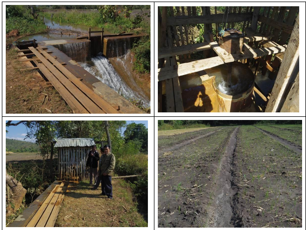
Segyi Right Canalに設置された小水力発電機
