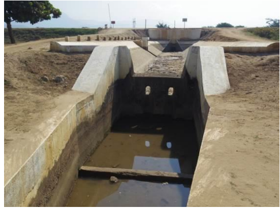
マンダレー管区・落差工
