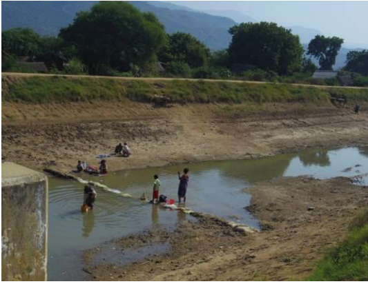
マンダレー管区の灌漑水路
