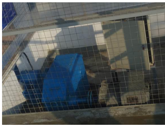
Taungnyo Damからの水路に設置されているチューブラ水車：15KW
