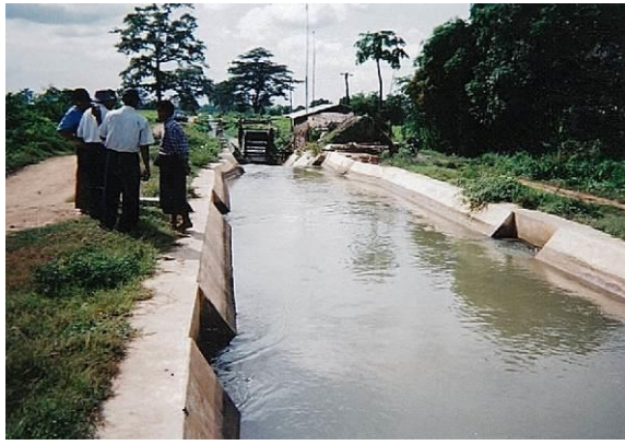
Latkaung Canalの落差工に設置された発電用水車
