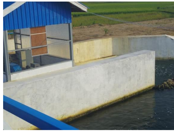
Taungnyo Damからの水路に設置されているチューブラ水車：15KW
