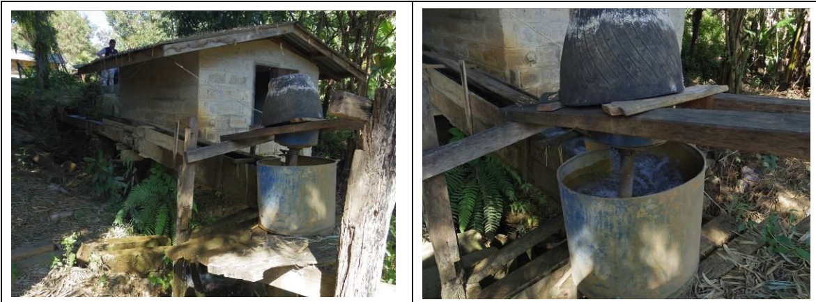
Segyi Left Canalに設置された小水力発電機
