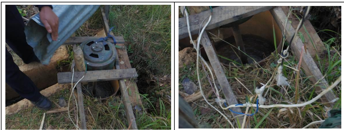
Zaugyi川脇に設置された小水力発電機および配線
