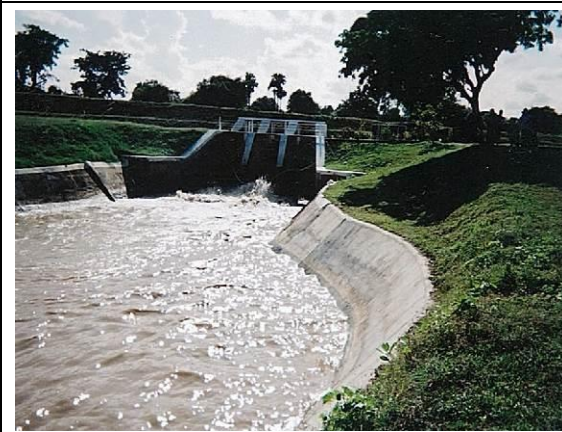
Myaungmataw Drainの落差工
