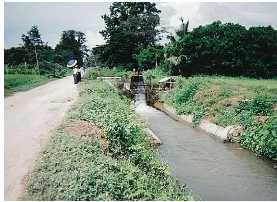
Alebon Canalの落差工に設置された発電用水車
