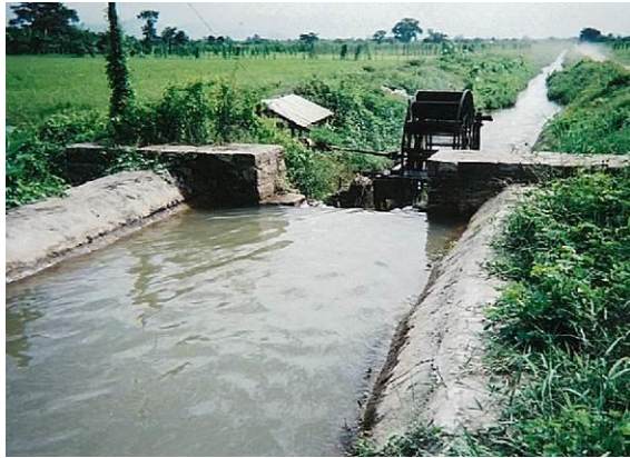
Alebon Canalの落差工に設置された発電用水車
