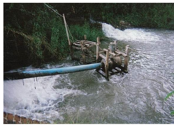
Pheeddarkat Canalの落差工に設置された小水力発電機
