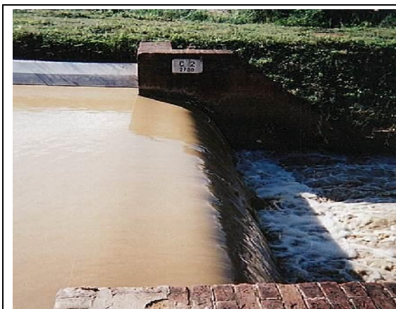
Linzin Weirからの水路
