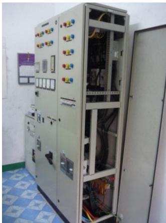
Dharavandhoo 発電所の発電機制御盤
