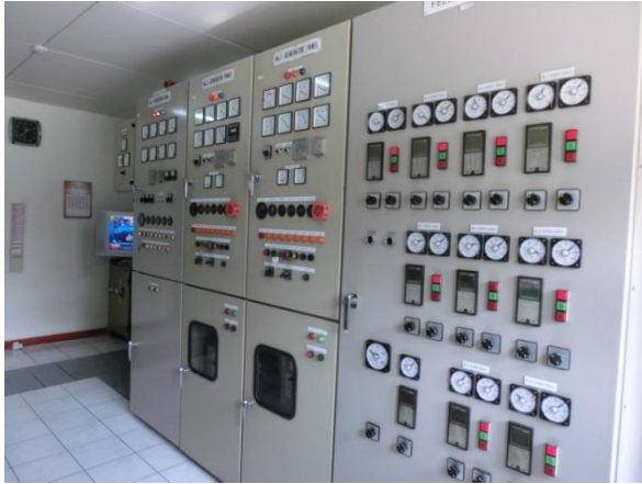
Eydhafushi 発電所の発電機制御盤
