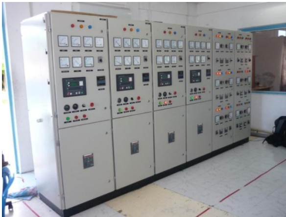
Thu Ihaadhoo 発電所の発電機制御盤
