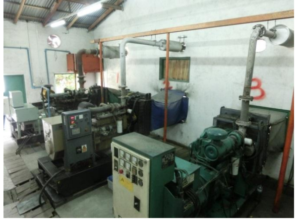
Dharavandhoo 発電所のディーゼル発電機
