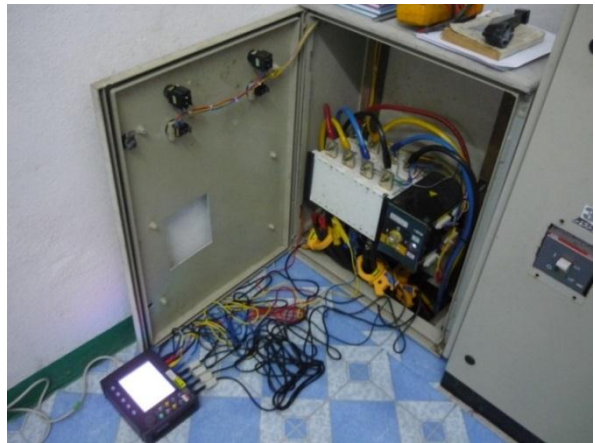
Dharavandhoo 発電所での電力計測の様子
