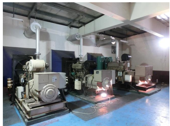
Eydhafushi 発電所のディーゼル発電機
