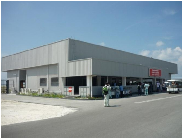
Dharavandhoo 島のエアポート
