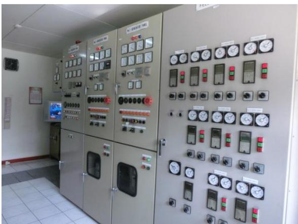
図 3-2-1. 21 発電機制御盤
