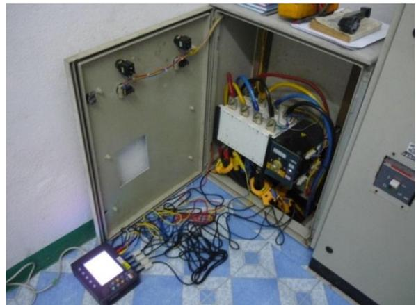
図 3-2-1.6 電力計測の様子
