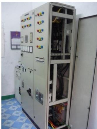
図 3-2-1.5 発電機制御盤
