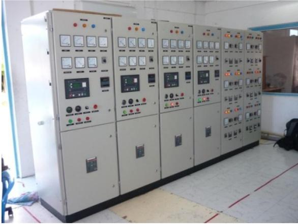
図 3-2-1.43 発電機制御盤
