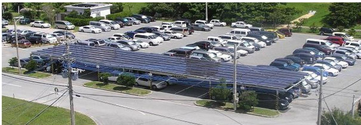
図 1-2-5.3 カーポートタイプの PV システム(沖縄)
