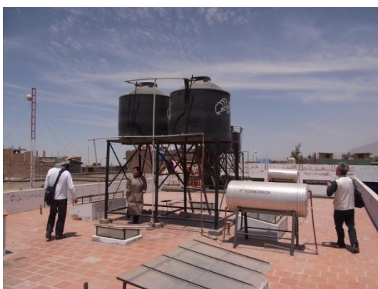
診療所の屋上に設置された貯水タンク (アレキパ州アレキパ)
