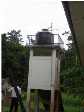
保健所の上水と接続した貯水タンク (ロレト州イキトス)
