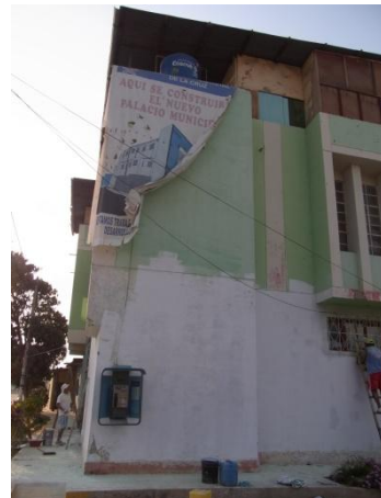
改修中の市役所 (トゥンベス州ラクルス)
