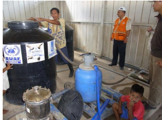
スペイン NGO によって導入された 浄水施設 (ロレト州ベレン)
