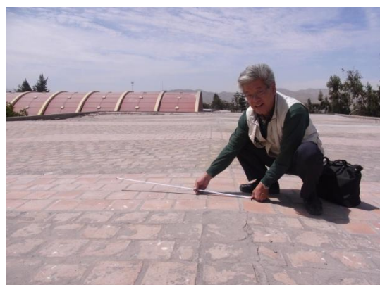
勾配のついた学校の屋上 (アレキパ州アレキパ)
