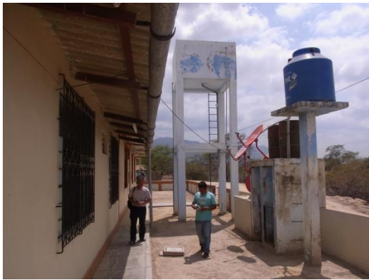
診療所に設置された貯水タンク (トゥンベス州カシータス)
