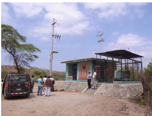
上水施設の建屋 (トゥンベス州カシータス)
