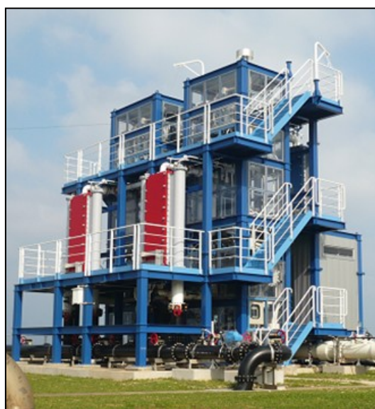
図 2-2 OTEC 実証試験機 (久米島)
