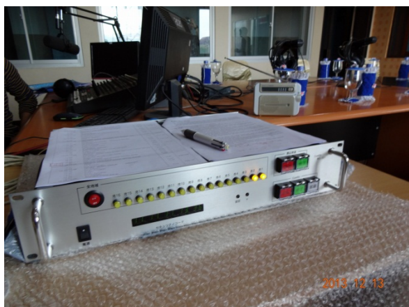
緊急告知ラジオと緊急告知信号発生器 (RRI マナドに設置)
