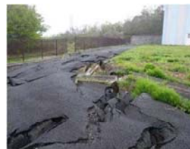
b) 周辺地盤の地割れ
