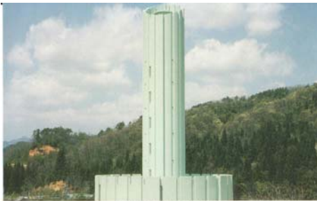
福井県・朝日町 中央地区統合農畜水道事業配水池築造工事 高区 容量=87m 3 内径=6.8m 有効水深=3.0m No.129 低区 容量=約1,280m 3 内径=24.3m 有効水深=5.0m 低区 容量=内 889m 3 内径=15.6m
