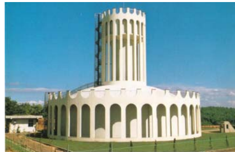
金ヶ崎町上水道第三次拡張森山配水池工事 二重高架水槽 (Va=3,500; D=27m; He=6m) No.29 (Va=150; D=8m; He=3m)
