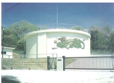
長野県・御代田町 平成9年度国庫補助御代田町配水池築造工事 容量 Ve=1,070m 3 内径 D=16.0m 有効水深 H=5.3m
