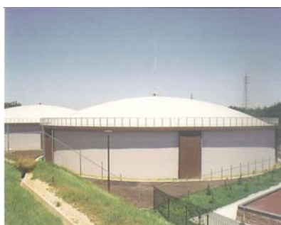
岐阜県・東濃用水道事務所 肥田調整池建設(PCタンク)工事 容量=11,500m 3 ×2池 内径=42.8m 有効水深=8.0m No.144
