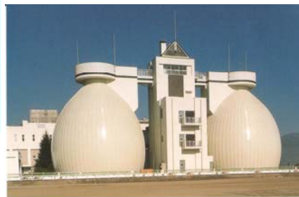
長野県・諏訪市 諏訪湖農田排水処理場建設工事 容量=4,600m 3 内径=MAX19.0m 有効水深=26.0m
