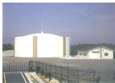
愛知県・全農庁 三ヶ峰広域調整池築造(その2)工事 容量 V=7,500m 3 内径 D=33.0m 有効水深 He=9.0m No.178
