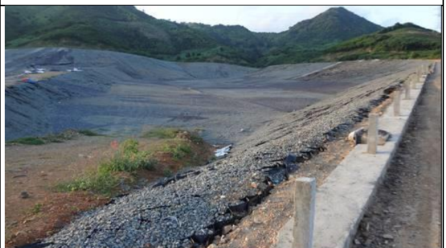
ニャチャン市の新規処分場。世界銀行のローンで建設中。2014年竣工予定。ほぼ完成している。
