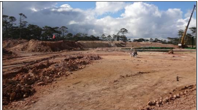
ダラットの間処理施設建設現場。強制好機性発酵と嫌気性発酵を組み合わせた最新式バイオ処理。
