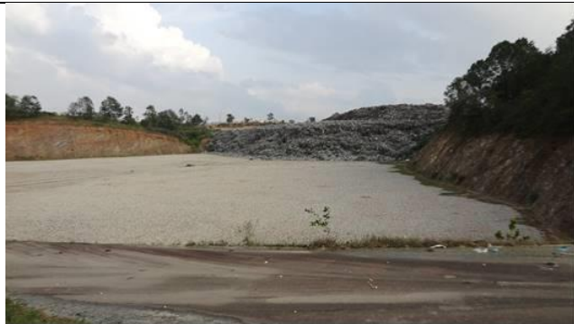
フエ市の処分場。とても良好に管理されている。
