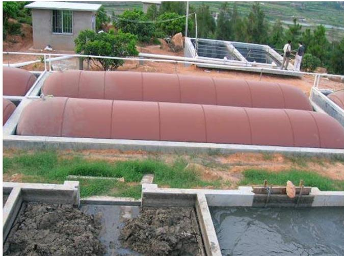
写真 5-1 袋タイプ 300m<sup>3</sup> バイオマス醗酵槽（中国）
