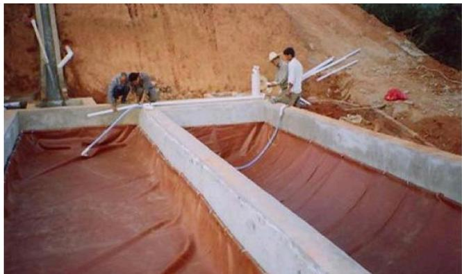
写真 5-3 袋タイプバイオマス醗酵槽建設状況（中国）
