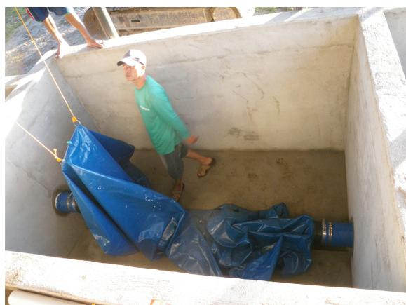
写真 3-4 バイオガス醗酵試験槽の建設
