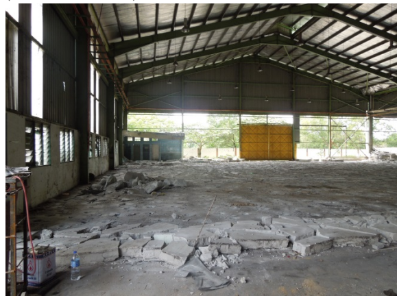
民間提案型普及・実証事業実施候補地の視察情景 (1)_Jaring Metal社フルリカバリー施設: 同社増築中 の施設内情景(パイロット機材設置可能地)
