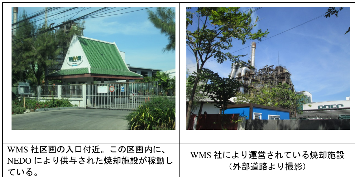
写真 1.3: NEDO の支援で供与された焼却施設(BPEC 敷地内)
