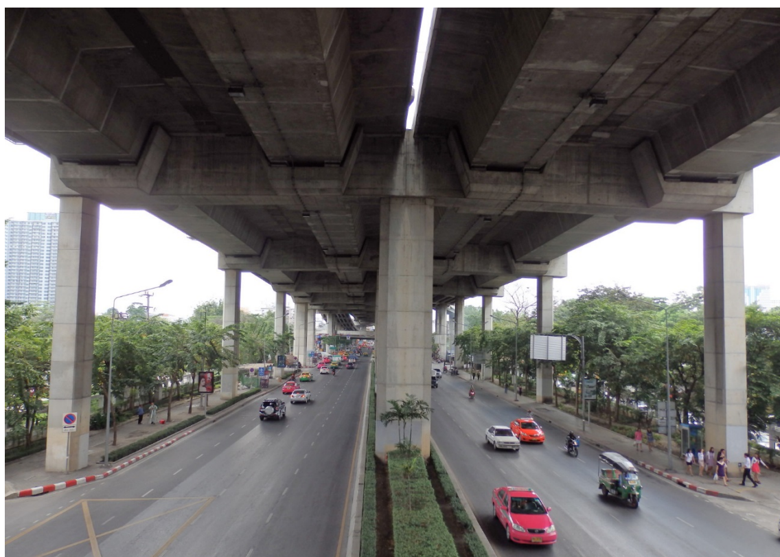
<図 3-12> DOH 計測対象構造物
