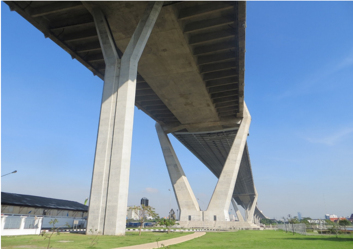
<図 3-3>DRR 計測対象構造物
