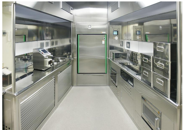
日本の調乳設備 (調乳エリア)
