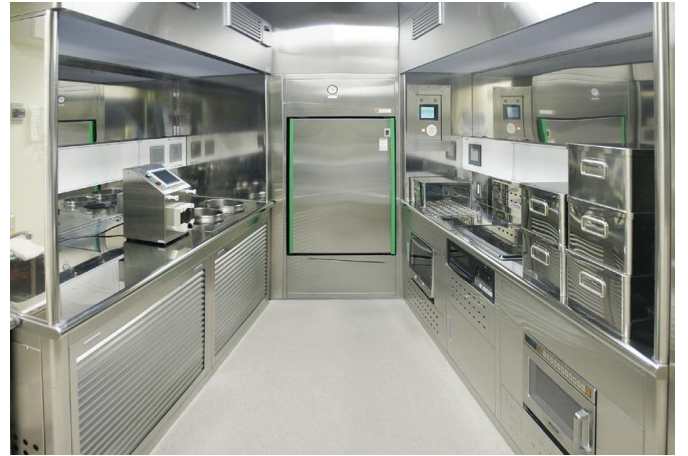
日本の調乳設備 (調乳エリア)
