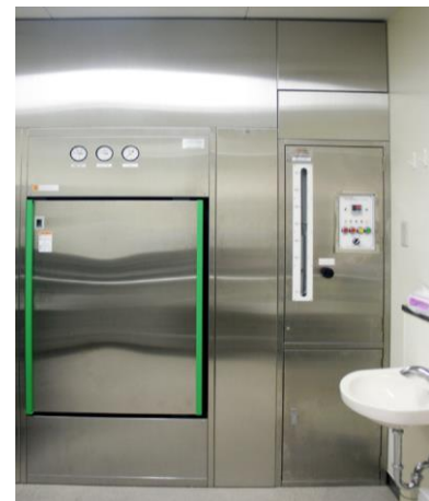
日本の調乳設備 (左から ターミナルスチーマー、 調乳水製造装置)
