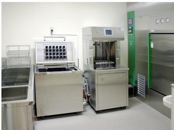
日本の調乳設備 (左から 予浸槽、ブラシ洗浄機、すすぎ洗浄機、 高圧蒸気滅菌機 )
