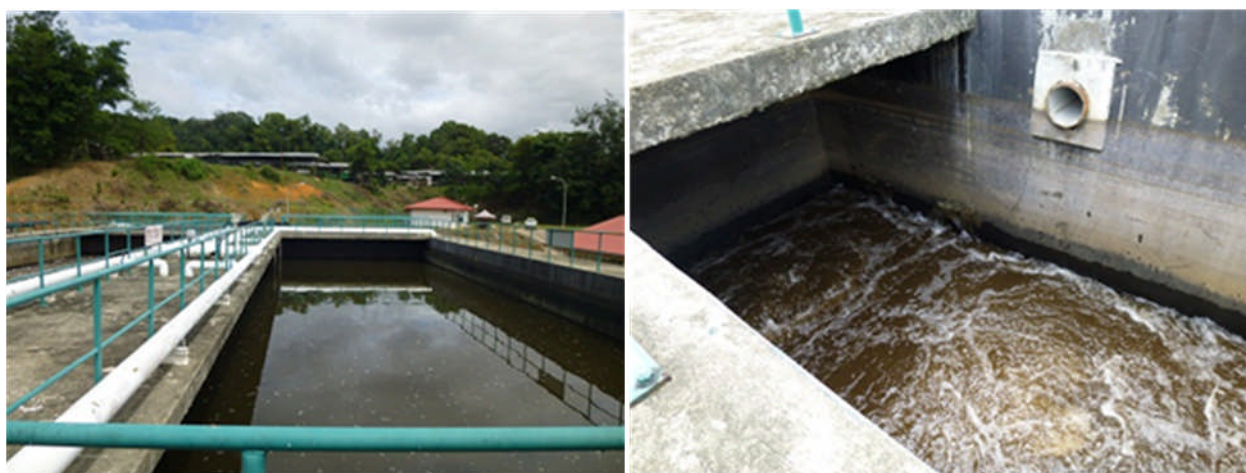
図 3-4-3 サバ州の小規模水処理施設の例 (左：小規模排水処理施設 右：排水口)
