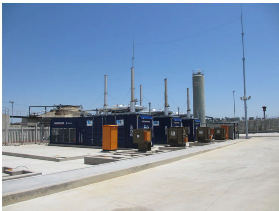
図 3-1-2 汚泥からのメタンガスによる発電施設 (JHB Water、Northern Waste Water Work)
