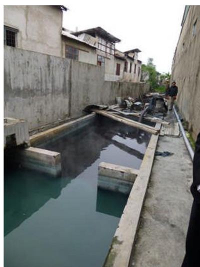
図 3-3-3 クラフトビレッジにおける排水処理施設
