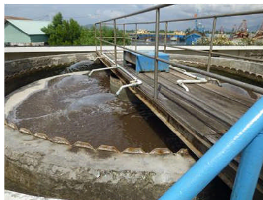
図3-3-2 ブンタウの水産加工工場における排水処理施設
