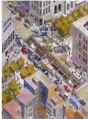
(開削工事による交通の寸断)
