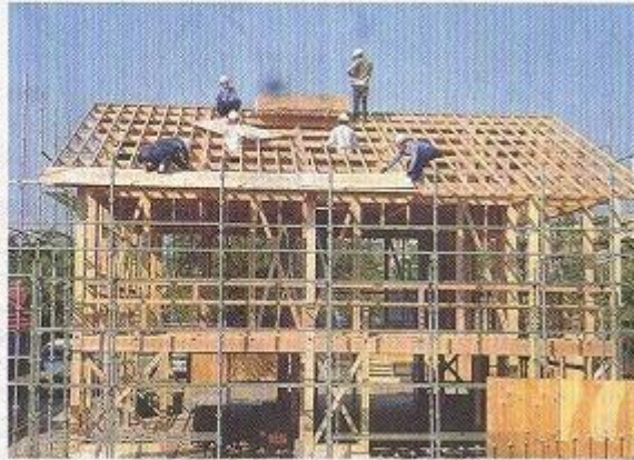
モデルハウスを建設するラオスと日本の作業員ら「いずれもラオス人民民主共和国のバクセで(西野工務店提供)
