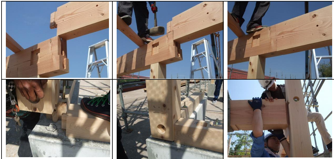
10.プレカット建材による構造建築
