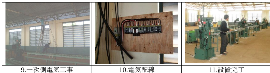
図 3-1 プレカット設備の搬入設置
