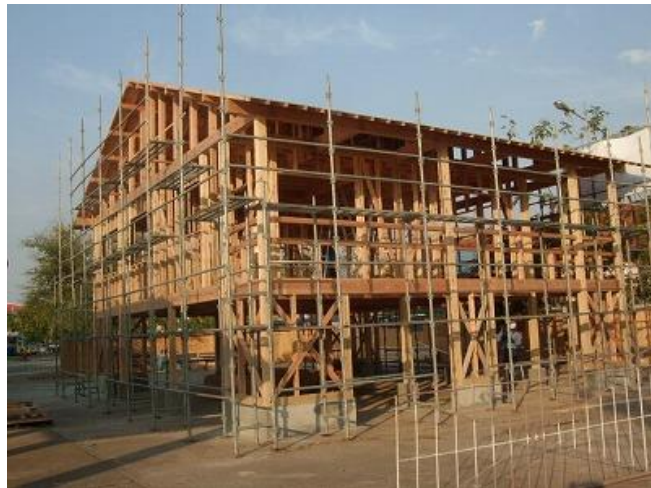
図3-5 プレカット工法による日本の在来木造建築構造
