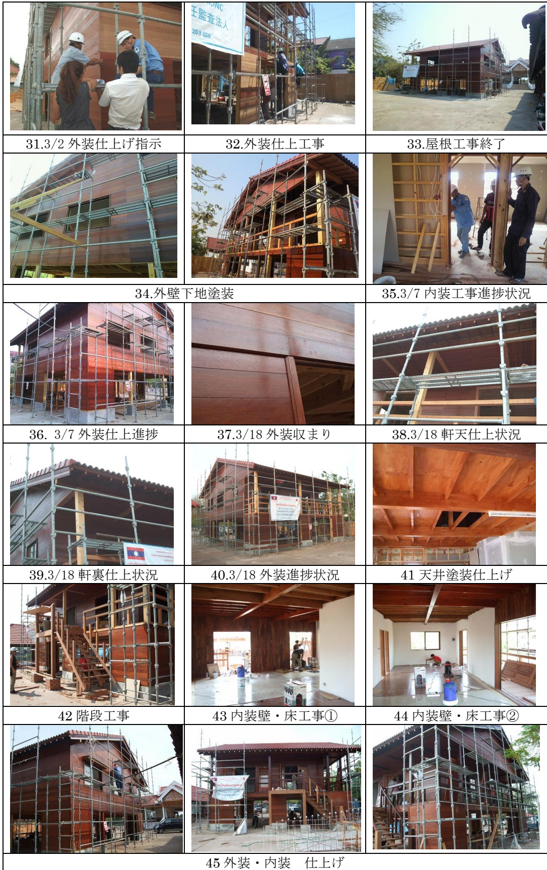
図 3-8 モデルハウス(外装・内装工事)
