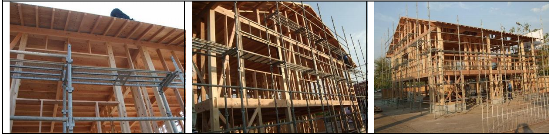
18.22時間後(3日目)建て方終了(プレカット建材構造部)
