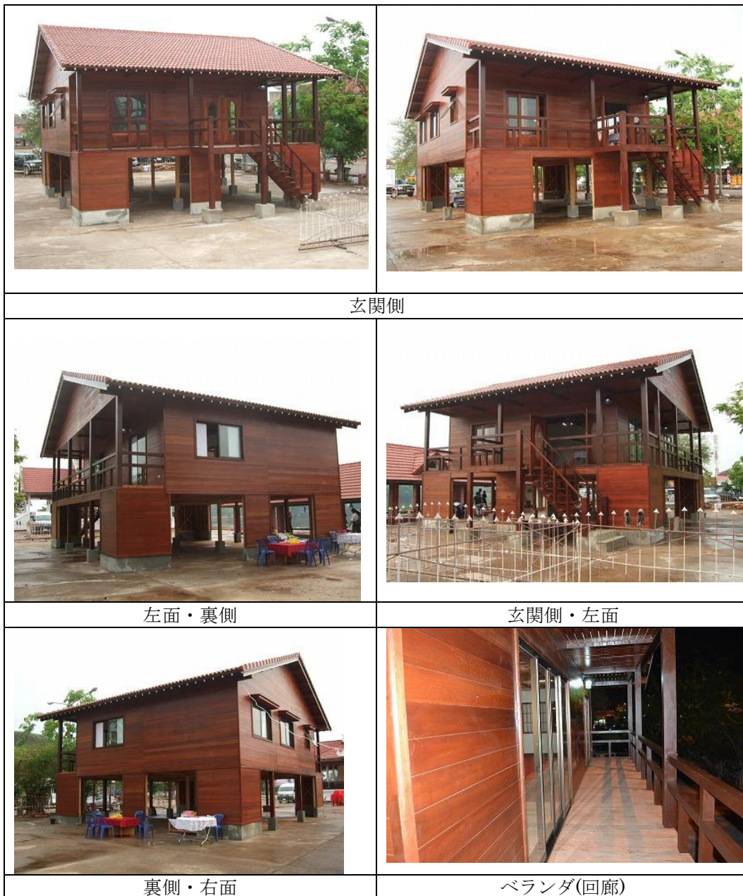
図 3-13 完成したモデルハウス外装
