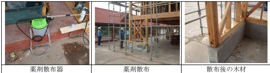
図 3-10 白アリ防除専用処理剤の散布
