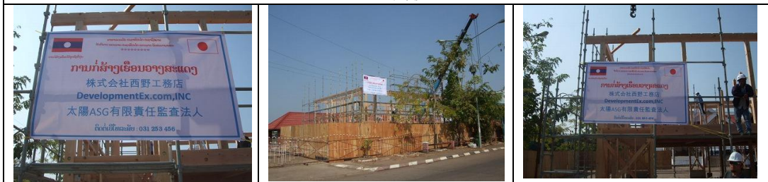
12.日本・ラオス合同の日本木造建築モデルハウス建築中を告知する看板の設置
