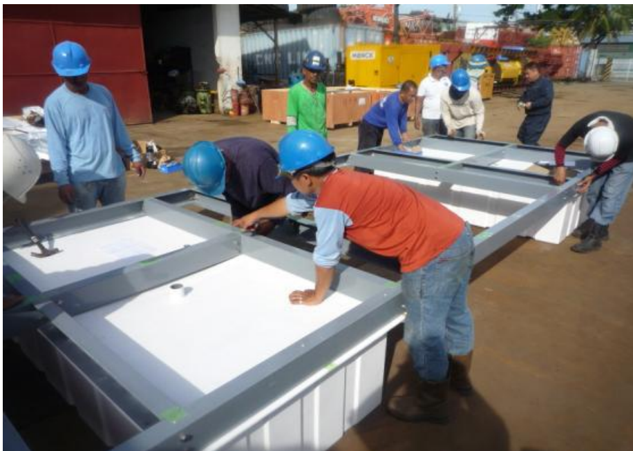
東洋建設作業所での組み立て作業
