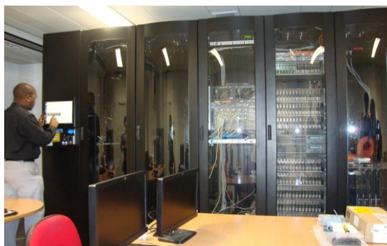
サーバー管理会社のデータセンター見学
