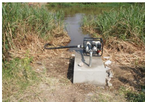
取水用ポンプスタンド
