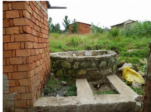
写真15 サイト1周辺 集落の便所のタンクがいっぱいになったため新たなタンクを建設中
