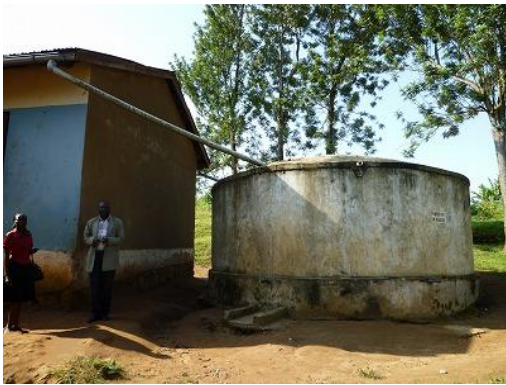
写真12 サイト1 ルェミシャニャ小学校の雨水タンク
