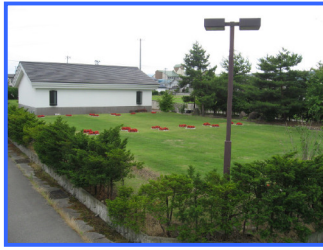
坂下西浄化センター
