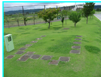
鶴沼公園合併浄化槽
