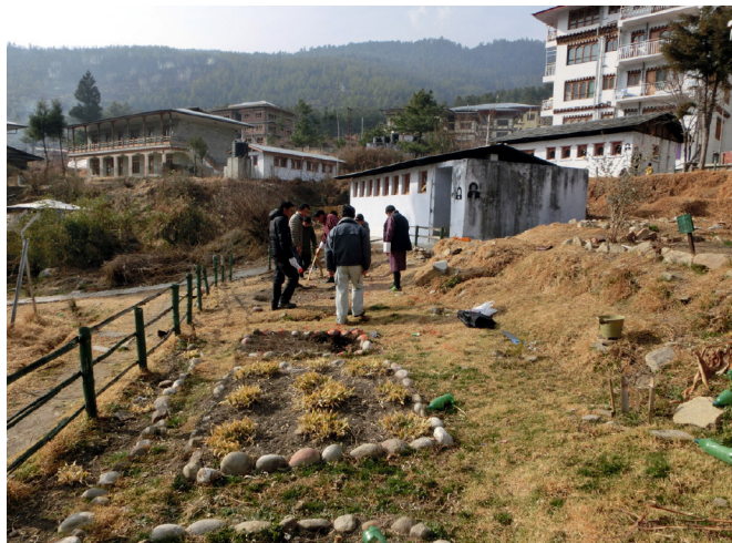
排水処理施設(沈殿分離槽+トレンチ)設置場所
