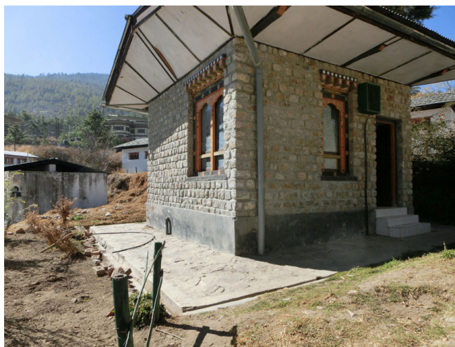
排水処理対象となる教員用トイレ棟
