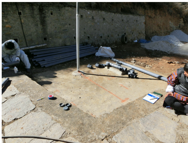
し尿セプティックタンク 土壌脱臭床施工場所
