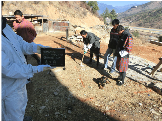
雑排水トレンチ施工場所
