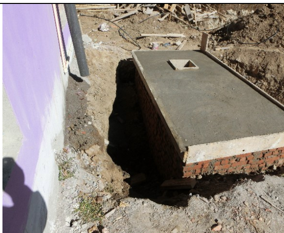
建設中のセプティックタンク
