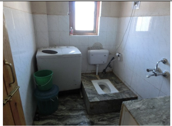
家庭の屋内トイレ その2
