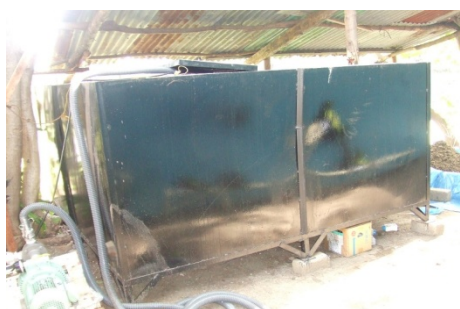
汚水貯蔵タンク
