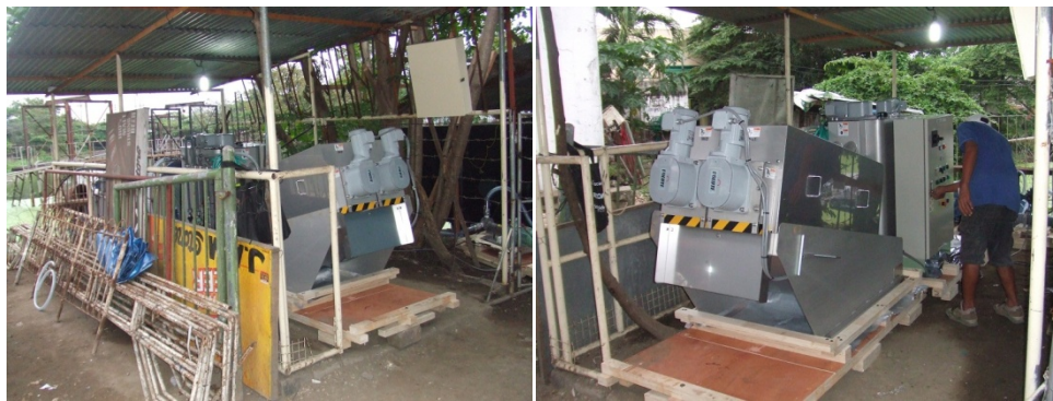
《その他設備の設置状況》
