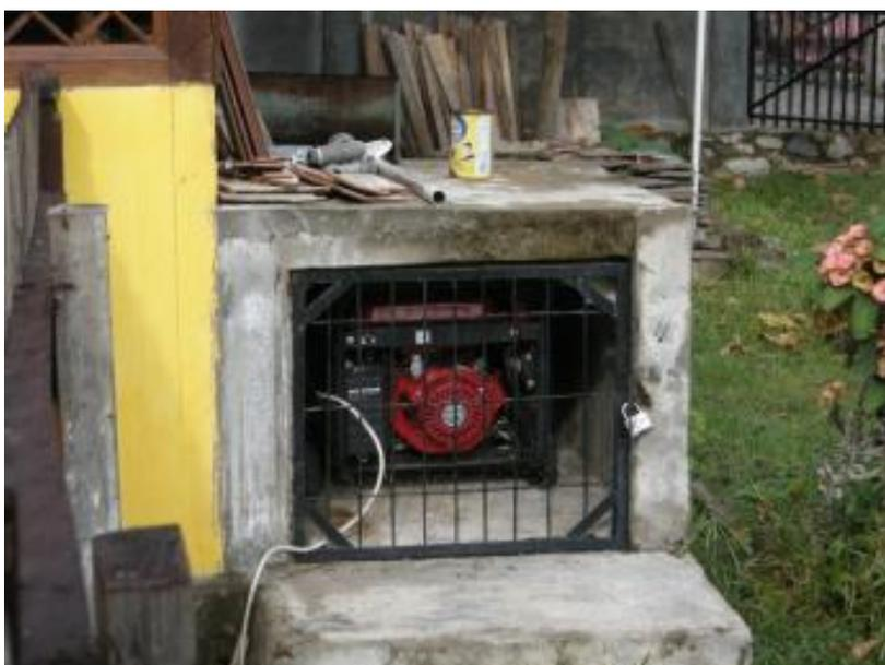
写真：宿泊した宿のディーゼル発電機。宿泊施設なので非常用の電源を持っており、停電しないようになっている。使用する電力は主に照明、扇風機、TVなど。ディーゼル発電機は貴重であるため、厳重に施錠されている。
