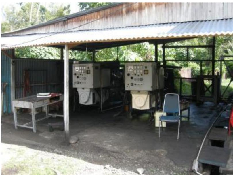
写真：PLM モリバグブランチのディーゼル発電所：発電機は7台で最大発電能力は2.4MWであるが、老朽化等の問題で、現在は5台1.2MWの稼働しかしていない。
