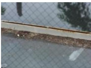
不適切な設置法がされているため、太陽光パネルの上にゴミがたまっている。これも発電効率を下げている。
