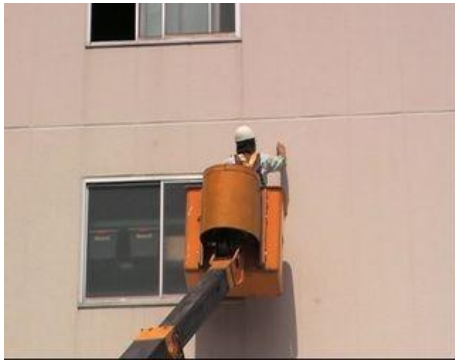
<写真 5> 高所作業者を用いた計測風景
