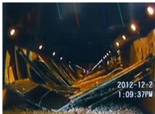
<写真4>日本 笹子トンネルの崩落(2012年)
