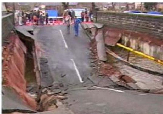
<写真3>イギリス Gwas 橋の落橋(1985年)
