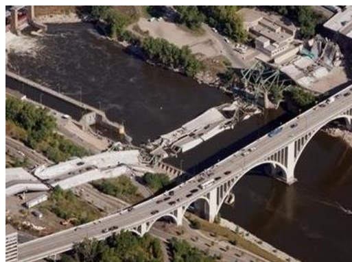
<写真2>アメリカ ミネアポリス橋の落橋(2007年)
