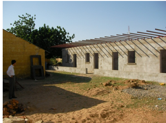
カッサラ盲学校 (建築中)
