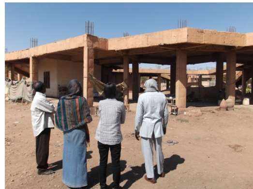
新エルヌール盲学校視察 (4階建て建設中断)
