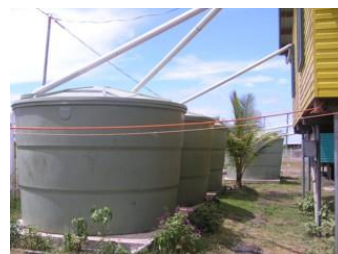
写真1 雨水貯水タンク
