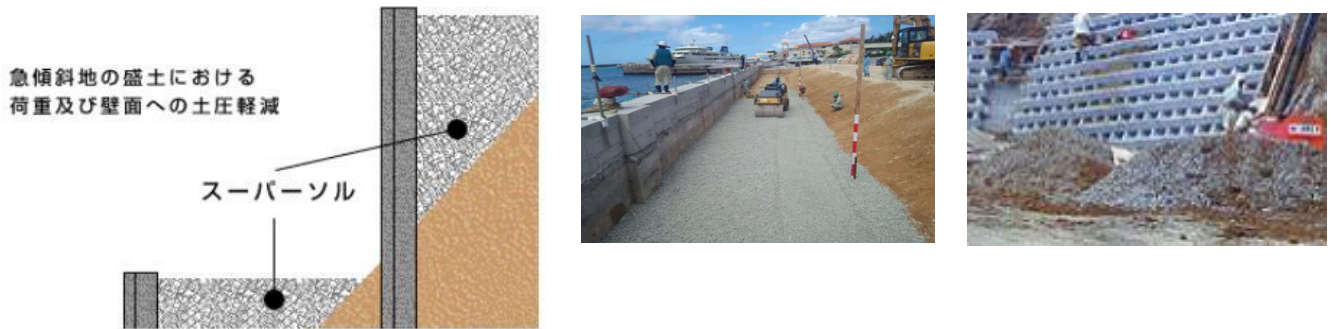
図7スーパーソルの岸壁、のり面の裏込め材としての利用
