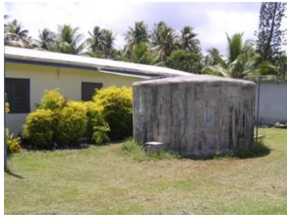
郊外のヘルスセンターのセメント製の水タンク。壊れて久しく使われていない。
