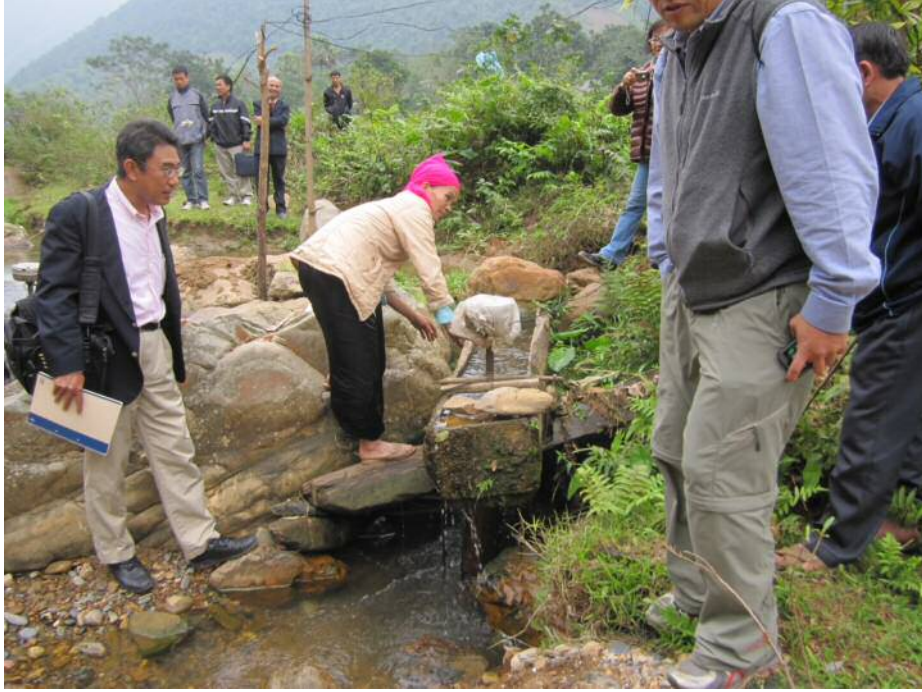
図1 写真 ベトナム Hoa Binh 省 So 地区の住民が管理するピコ水力発電機
