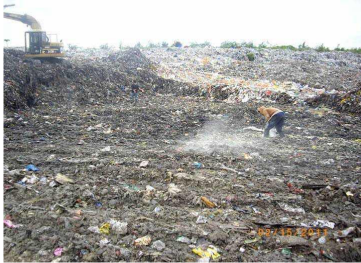
図 1-19 脱臭剤散布状況
