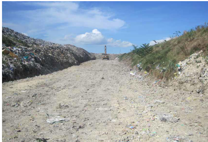
図 1-18 搬出用道路の確保状況
