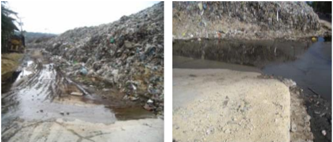
図 1-16 搬出口用コンクリート道路に流れる浸出水
