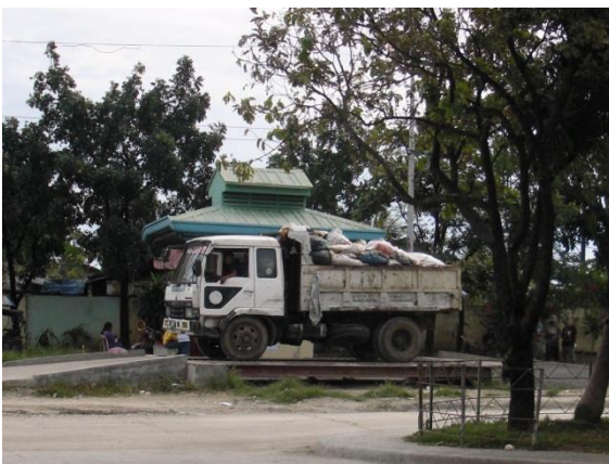
イナヤワン事務所棟前トラックスケール
