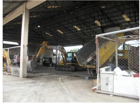
イナヤワン重機保管棟
