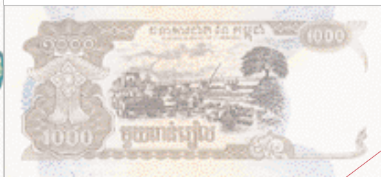
カンボジアの国道6・7号線の工事風景がデザインされたカンボジアの紙幣
