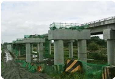
日本企業が円借款で建設中の橋梁
