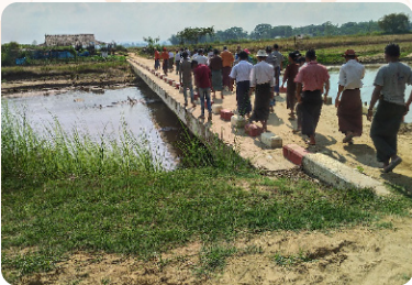
◀ N連による沈下橋の建設及び技術移転事業(受益者が橋を利用する様子)
