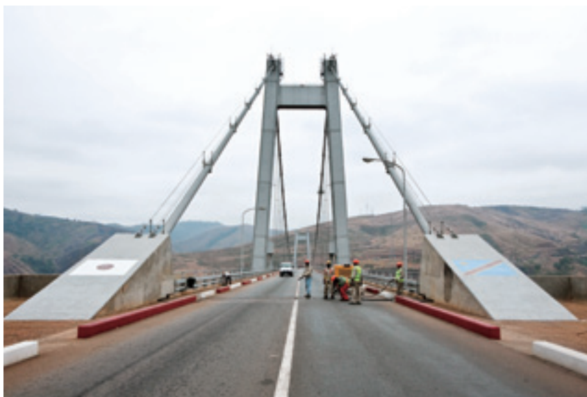
1983年に日本の協力により建設された、コンゴ川に架かる唯一の吊り橋、通称「マタディ橋」。完成後すぐに紛争が始まってしまったが、日本人技術者からの技術移転が功を奏し、30年以上経った現在もしっかり維持管理されている。日本とコンゴ（民）の友好のシンボル。(写真：久野真一/JICA)
