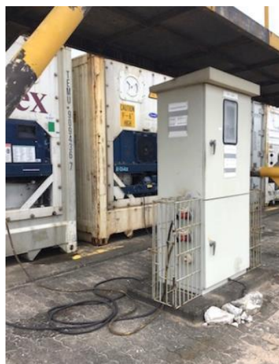
図 53 シアヌークビル港の冷蔵冷凍コンテナ係留電気設備
