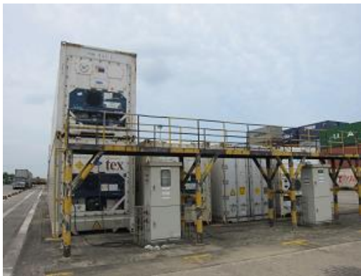
シアヌークビル港の冷凍・冷蔵コンテナ保管場
