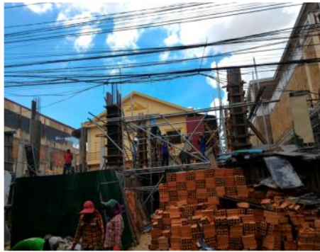
図 24 プノンペン市内の住宅建設工事現場
