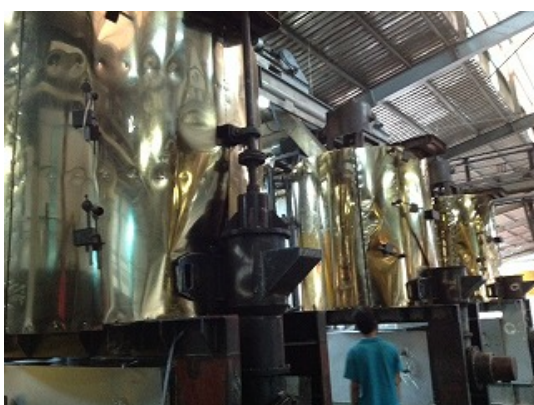
15. 民間製油工場施設
