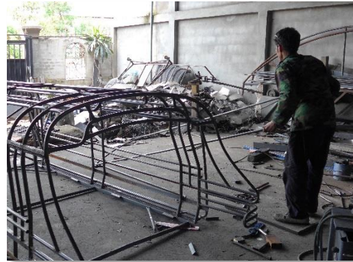
ソントウ改装工場の様子
