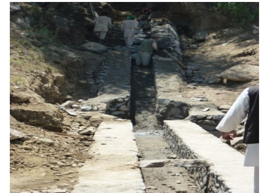
FAO支援の下、灌漑施設整備を行う現地コミュニティ
