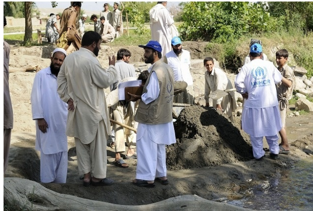
灌漑施設の建設
