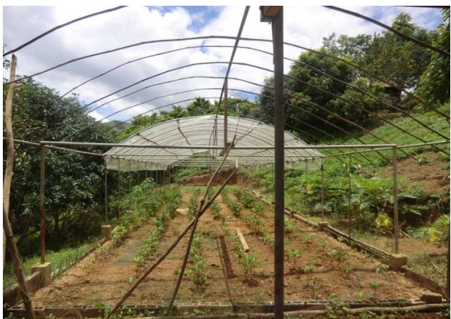
写真6. 建設中の雨除けビニルハウス
