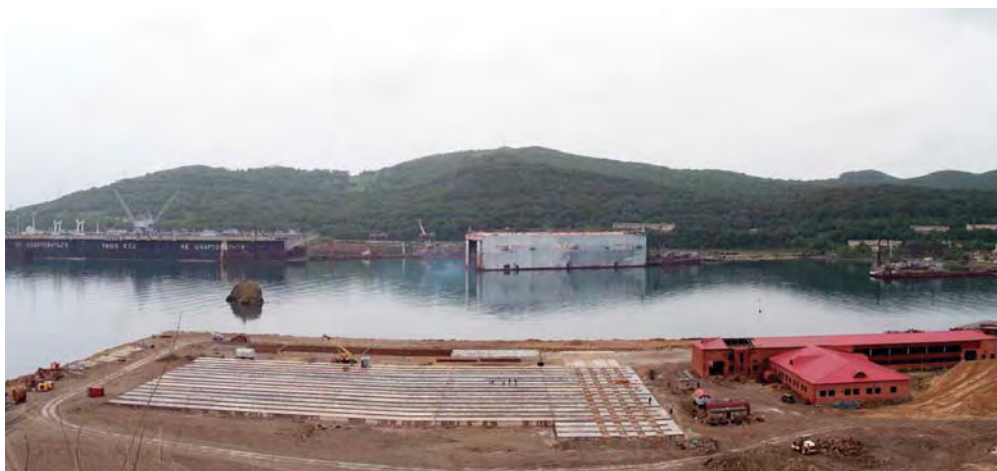
原子炉区画陸上保管施設建設現場〈ラズボイニク湾〉
