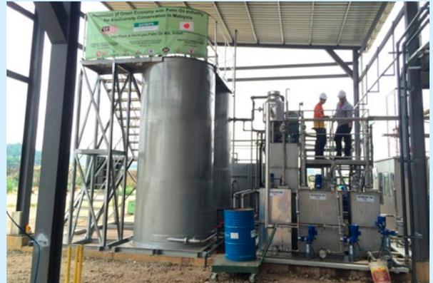
パームオイル廃液を処理し、燃料となるメタンガスを発生させるための廃水処理装置（写真提供：白井義人九州工科大学教授）
